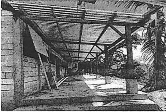
FOTO 1: INSTALACIÓN DE ESTRUCTURA DE METAL MAS LÁMINA
