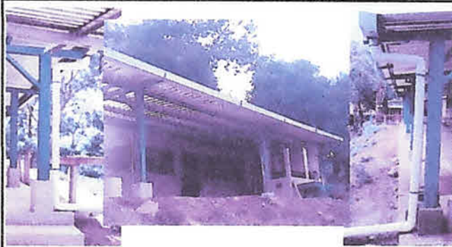
FOTO 3: INSTALACIÓN DE CANAL METALICO CON DOS BAJADAS PLUVIALES CON TUBO PVC DE 4"
