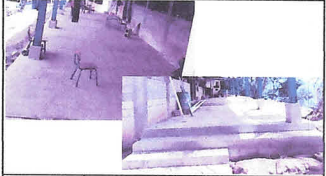
FOTO 2: FUNDICIÓN DE PISO DE CONCRETO
