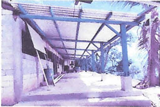
FOTO 1: INSTALACIÓN DE ESTRUCTURA DE METAL MAS LÁMINA
