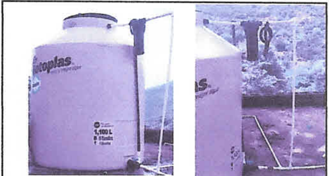
FOTO 4: SUMINISTRO E INSTALACIÓN DE TINACO MAS SUS ACCESORIOS
